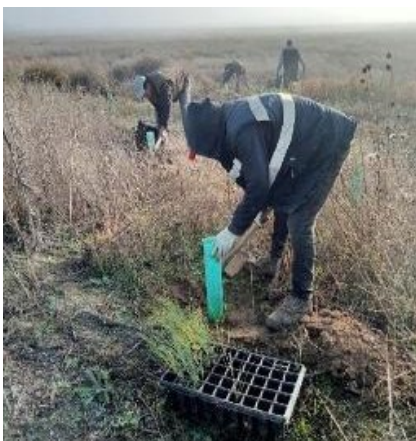
Reposición de marras en los taludes de cantera
